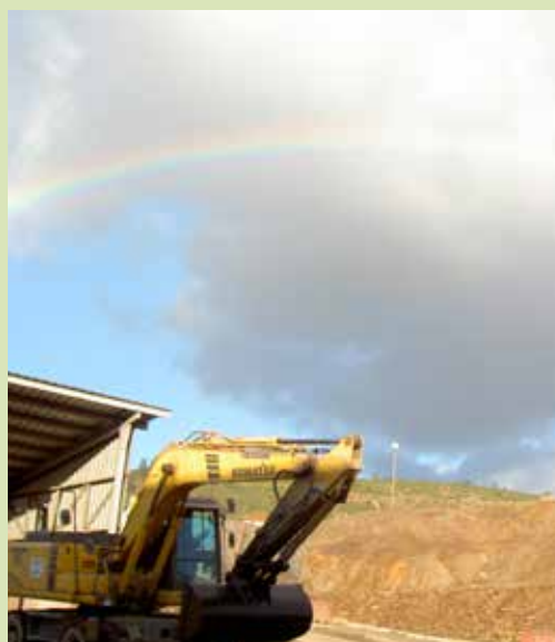
Instalaciones de Befesa en Nerva (España)
