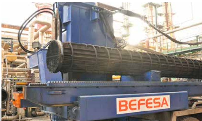
Limpieza robotizada de intercambiadores de calor.
