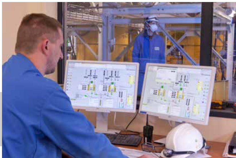
Sala de control de proceso de Befesa Zinc Gravelines (Francia).
