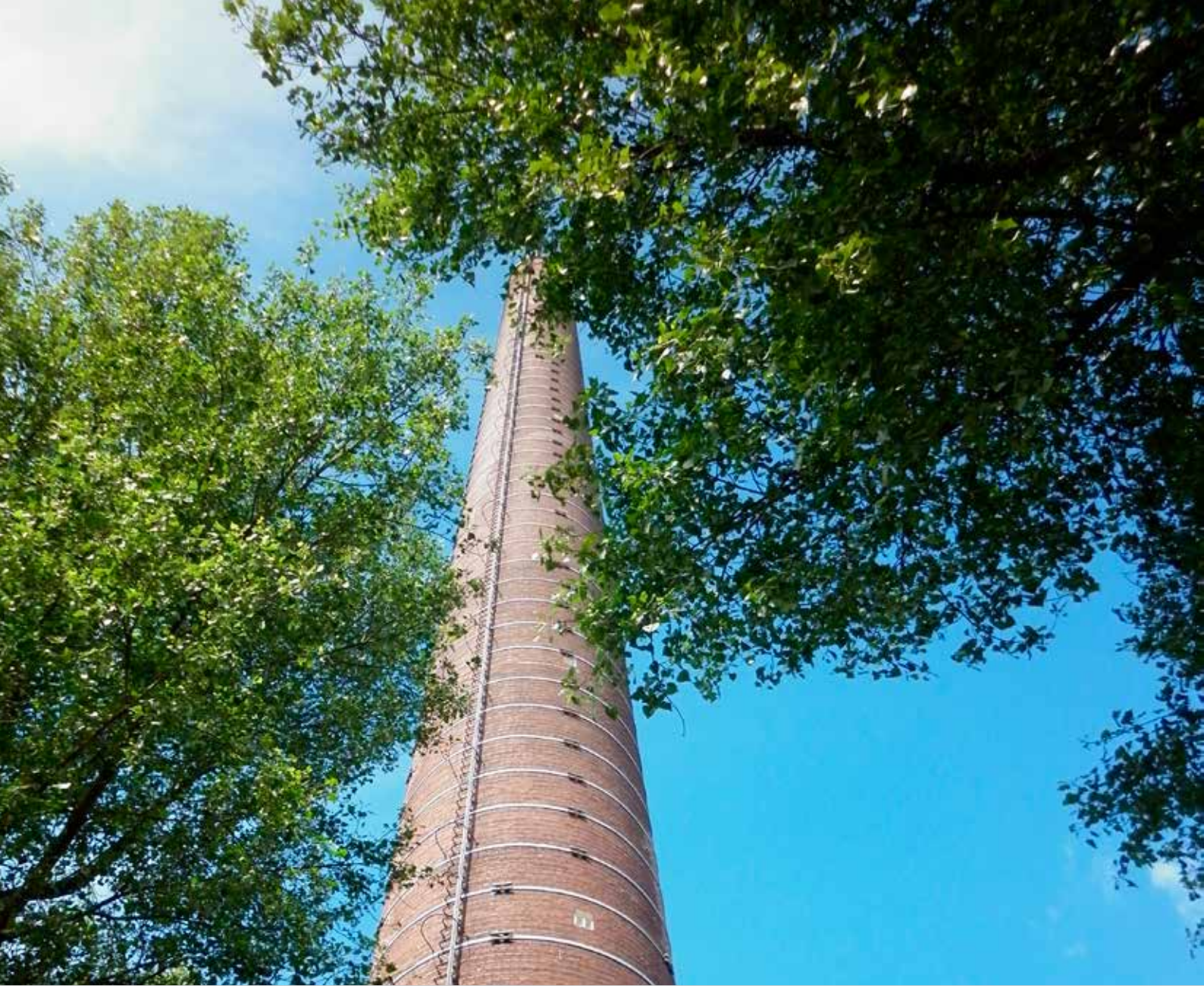
Instalaciones de Befesa Zinc Duisburg, Alemania.
