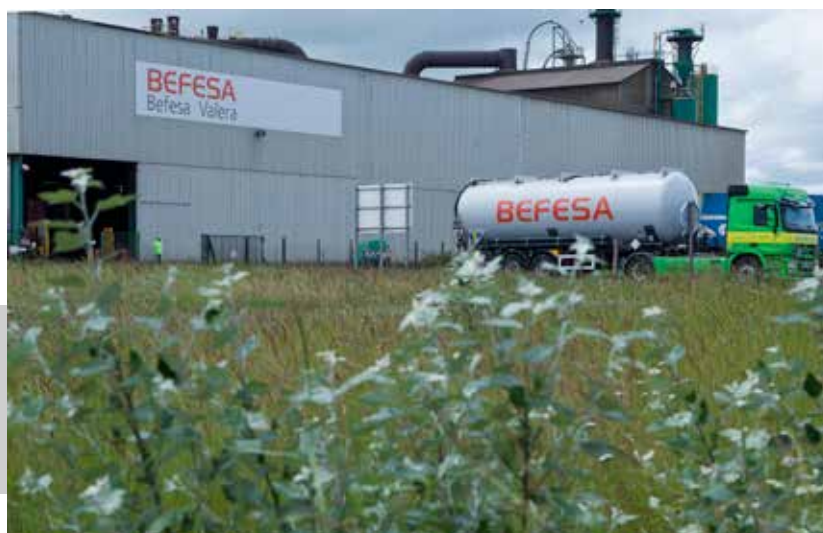
Vista exterior de las instalaciones de Befesa Valera (Gravelines), Francia
