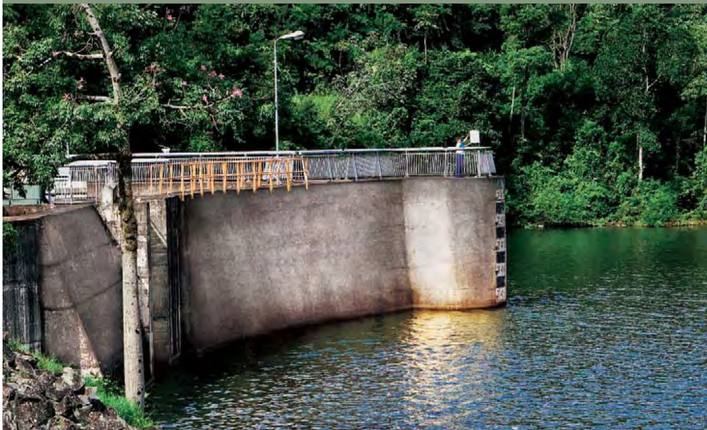
Paiva Castro Dam.
