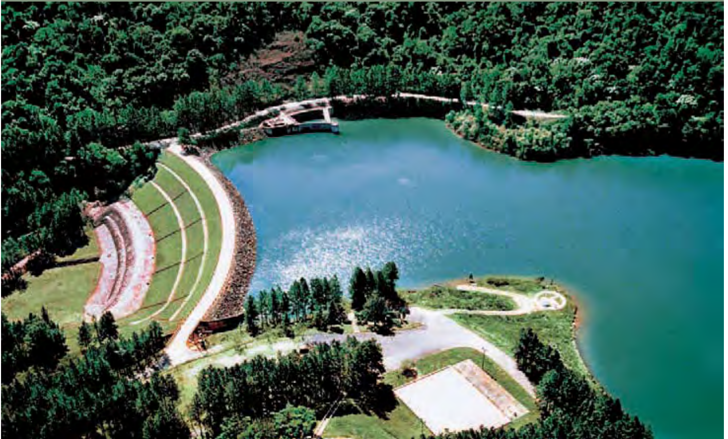
Paiva Castro Dam.
