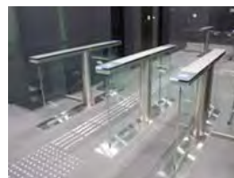
港南事業所のフラッパーゲート
