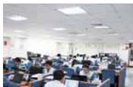
オフィスの照明をLED化
