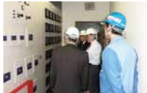
新宮事業所での省エネルギー推進委員会の現場パトロール
