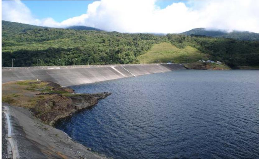
El embalse de Fortuna, con una longitud de 8 Km. y una anchura máxima de 1.3 Km. y una mínima de 0.2km, posee una capacidad de almacenamiento de 172.3 millones de metros cúbicos. Situado a 1000 m.s.n.m., constituye el reservorio para la generación de energía hídrica.
