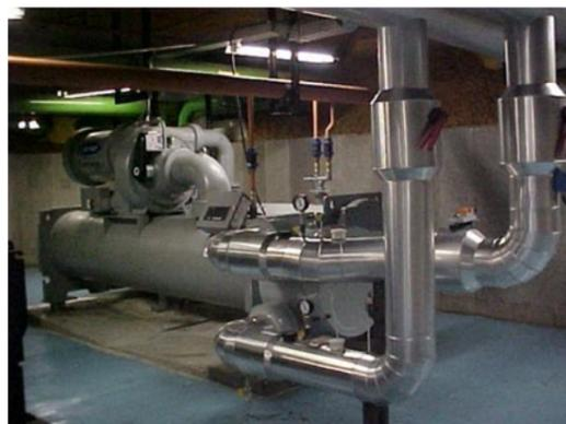
Instalação da terceira centrífuga da unidade resfriadora (sistema central de ar condicionado). O novo item, além de possibilitar uma manutenção preventiva mais tranqüila dos equipamentos existentes, propicia economia de energia elétrica, tendo em vista a nova tecnologia;
