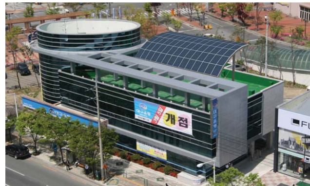
▲ 대구은행 태양광발전 설비(15kw) 설치
