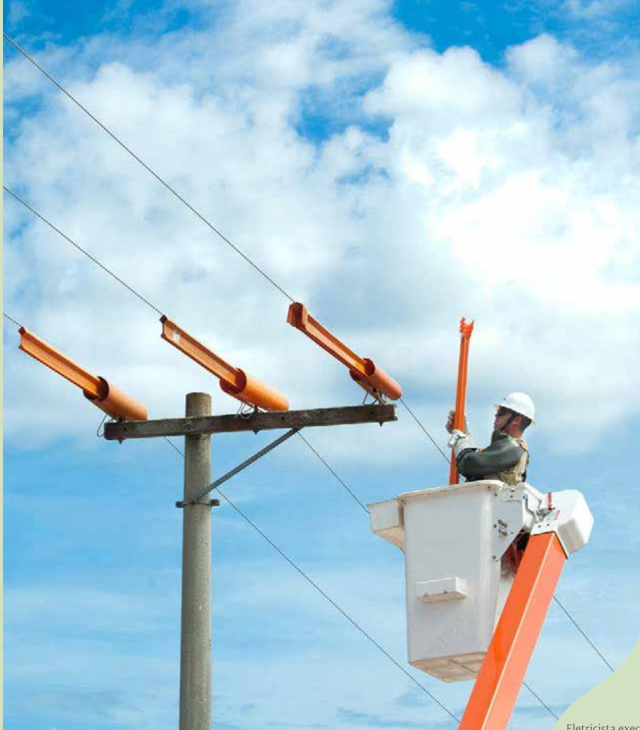
Eletricista executando atividade em regime de linha viva na rede de distribuição de Atibaia
