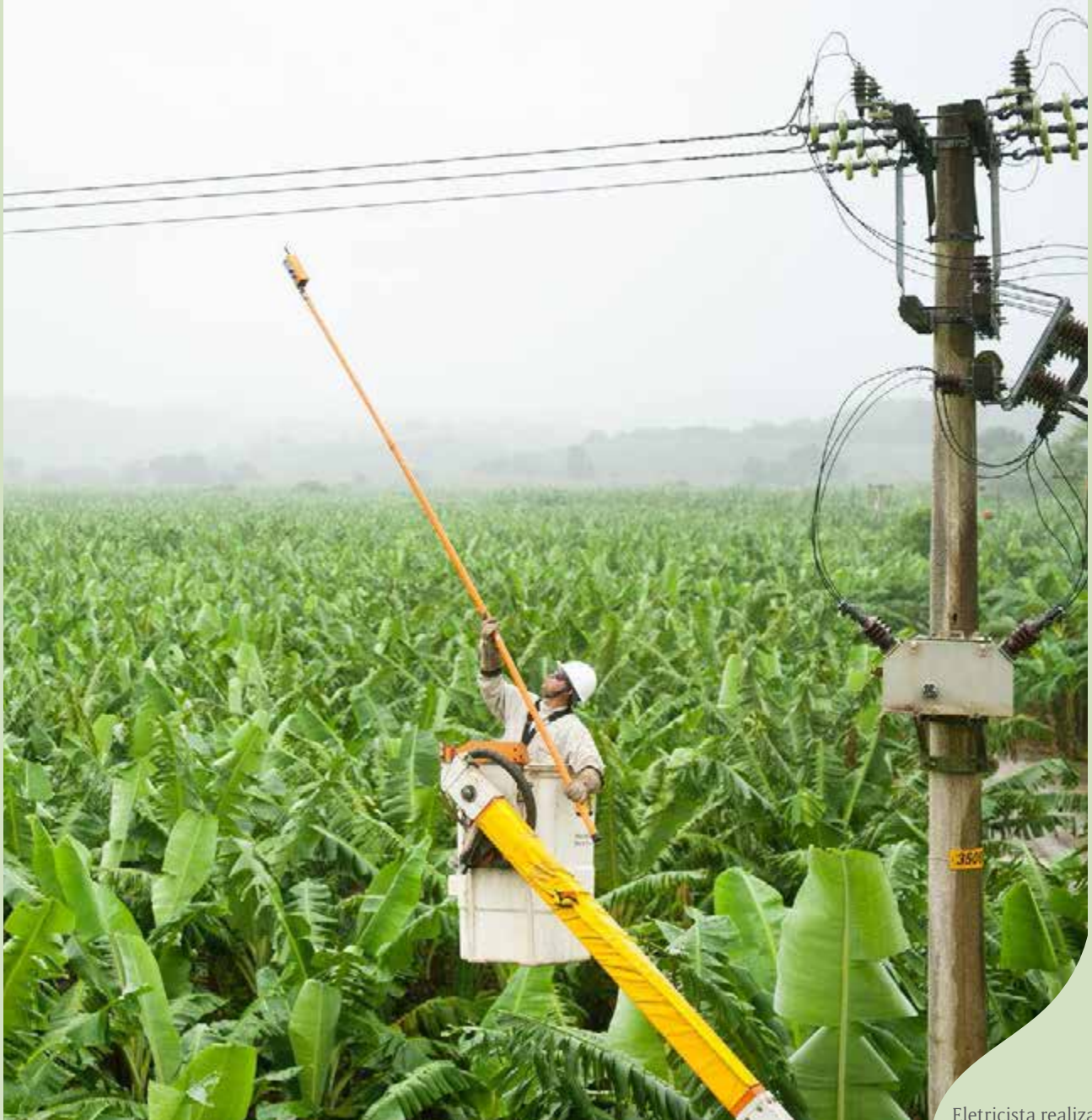
Eletricista realizando teste de ausência de tensão em rede de distribuição de 13.8 kV de Cajati
