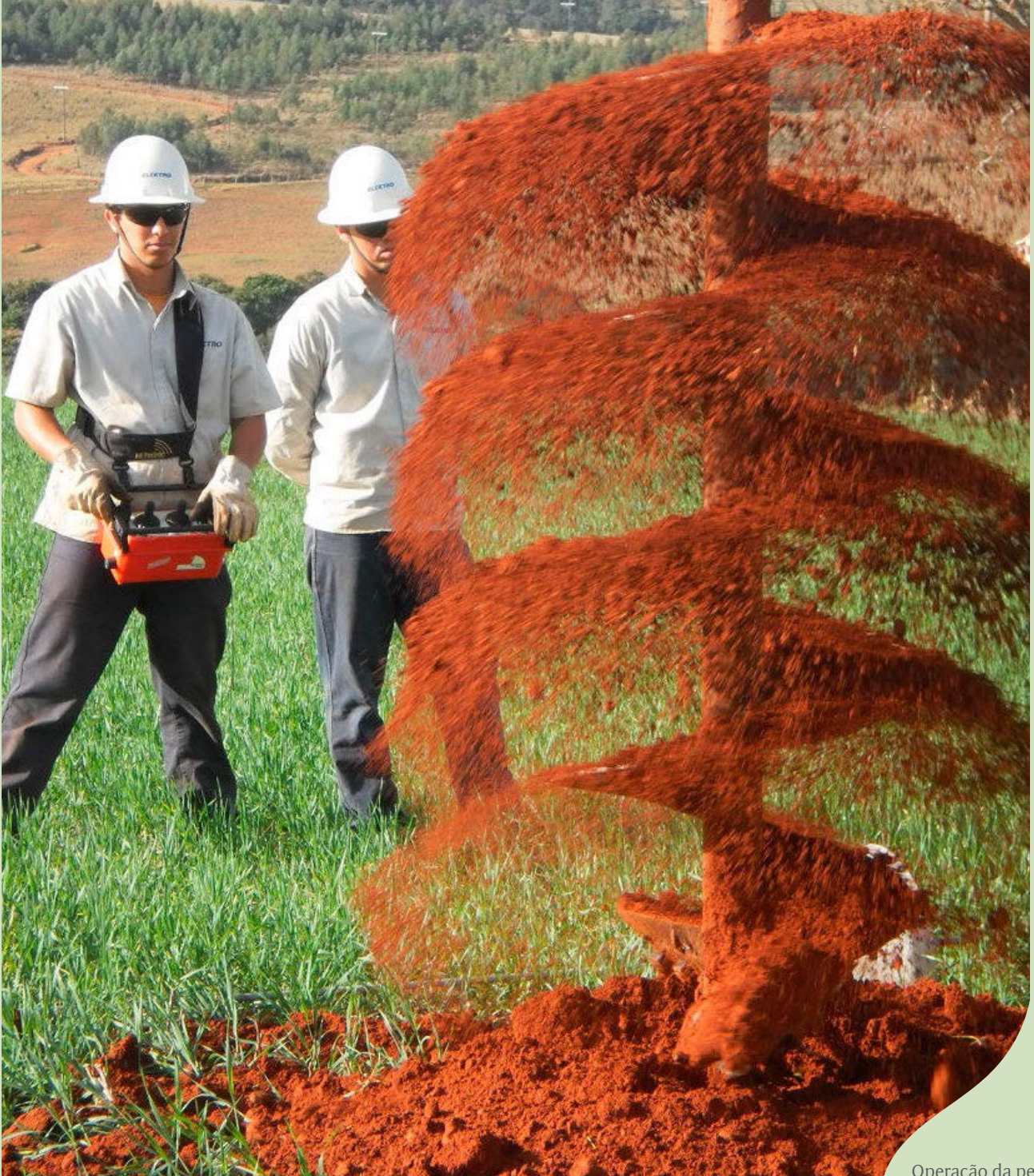
Operação da perfuratriz do equipamento Digger Derrick para implantação de poste
