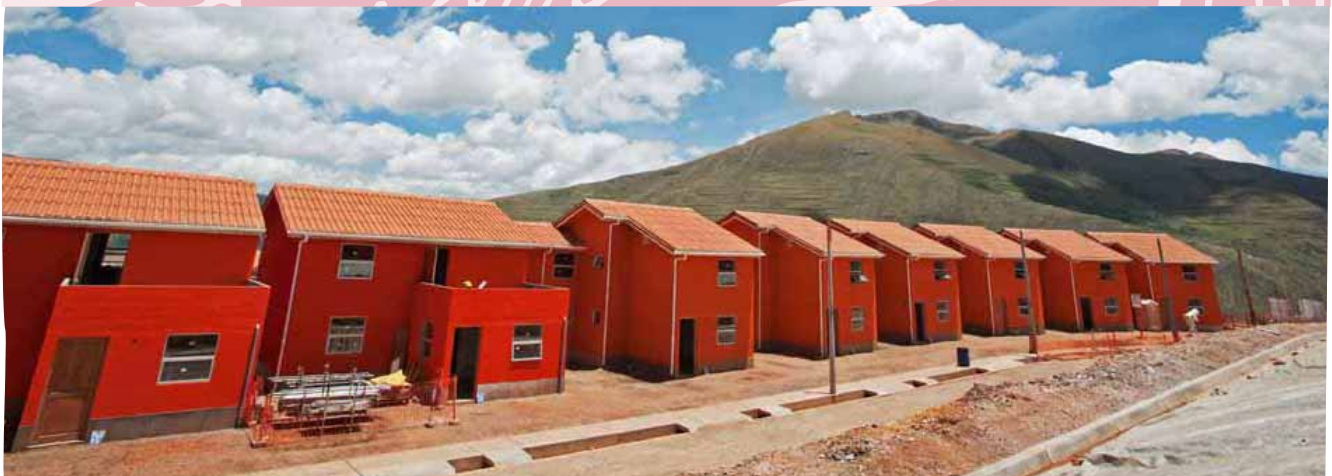
Construcción de Nueva Fuerabamba, comunidad que será habitada por las familias de Fuerabamba, según el acuerdo de reasentamiento.
