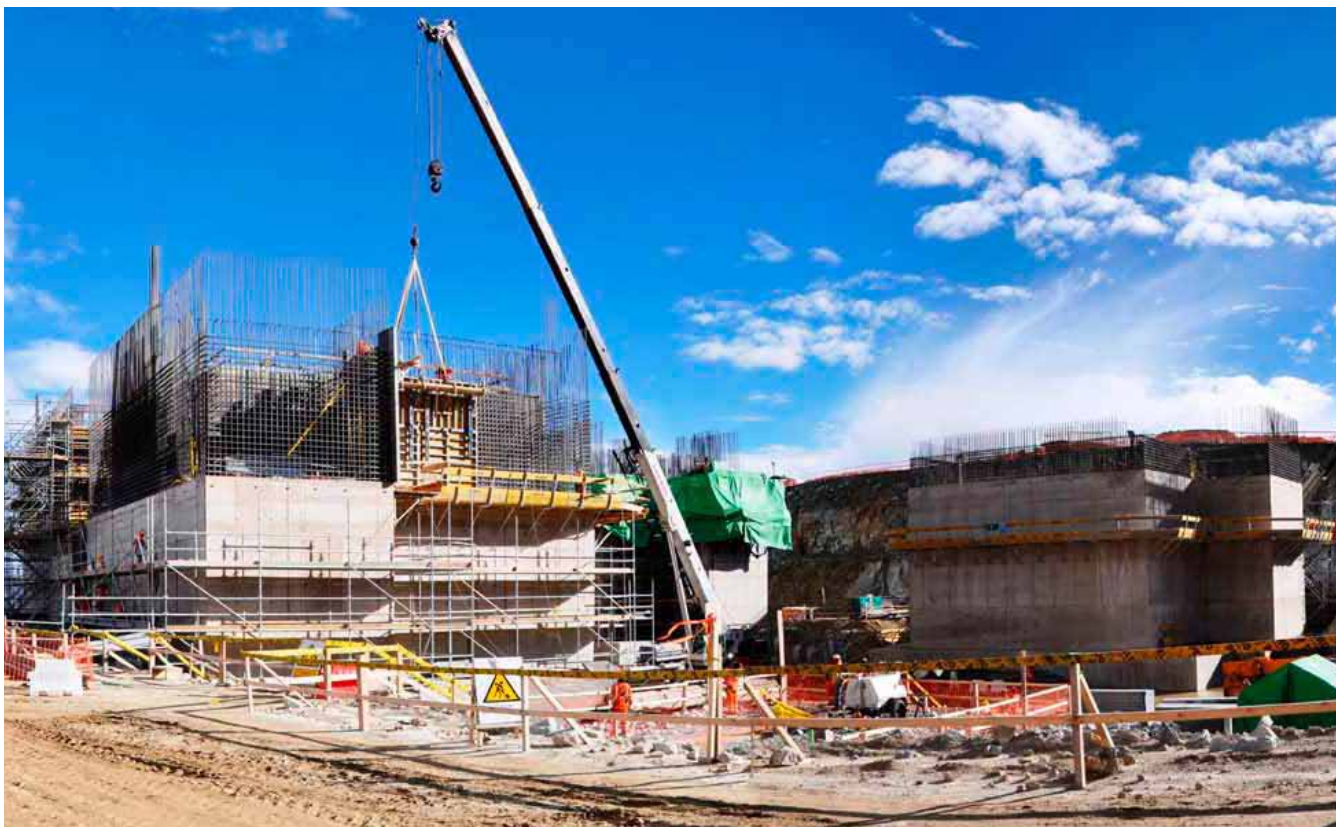
Construcción de la futura planta concentradora de Las Bambas.
