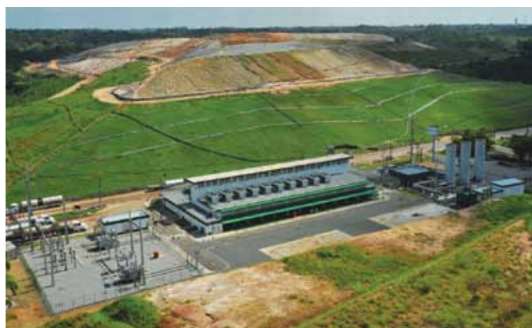
Vista panorámica de las instalaciones de Termoverde – Salvador, BA
