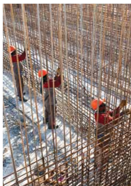
Construcción del sistema de abastecimiento de agua – Irerê, BA
