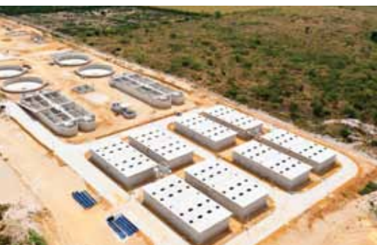
Estación de tratamiento de efluentes – Vitória da Conquista, BA
