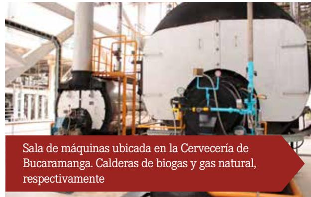
Sala de máquinas ubicada en la Cervecería de Bucaramanga. Calderas de biogas y gas natural, respectivamente
