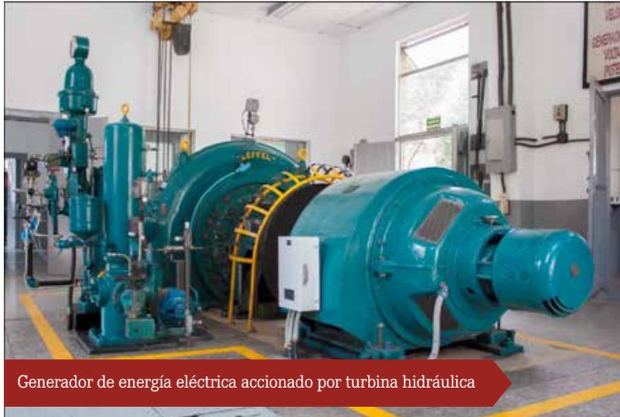
Generador de energía eléctrica accionado por turbina hidráulica
