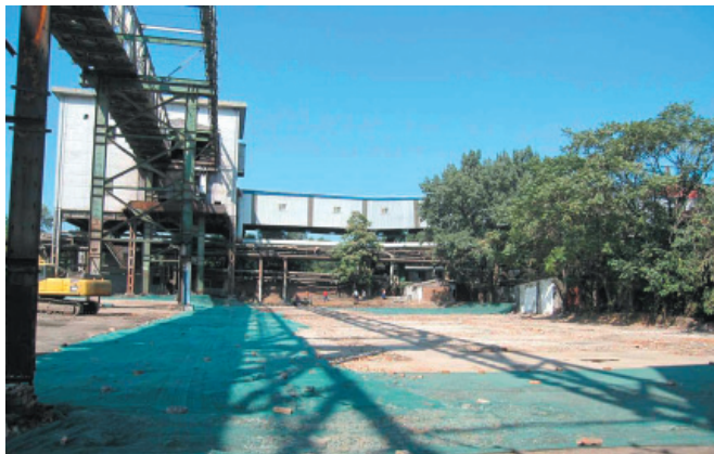
拆迁苫盖后的场地
