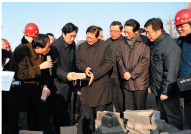
北京市领导到首钢生物质能源项目建设工地调研
