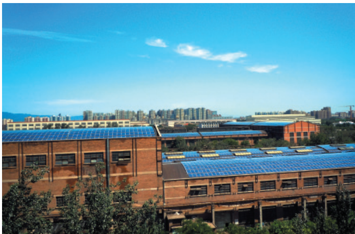
2兆瓦光伏屋顶发电项目落户园区
