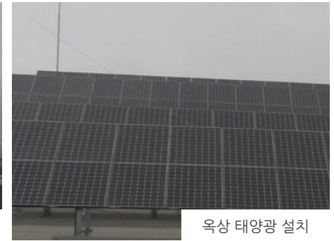
옥상 태양광 설치
