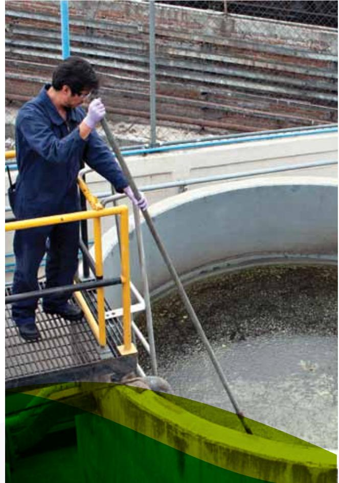
Adicionalmente, **Eli Lilly** cuenta con un sistema de captación de agua residual que consiste en cinco cárcamos localizados alrededor de las instalaciones. Su trabajo consiste en homogeneizar el pH, la temperatura y carga orgánica del agua residual antes del tratamiento biológico, con lo que se reduce al máximo el impacto dañino para los microorganismos encargados de la degradación de los contaminantes presentes en el agua.
