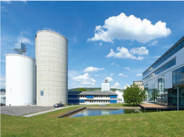
Holzspänesilos der VS
