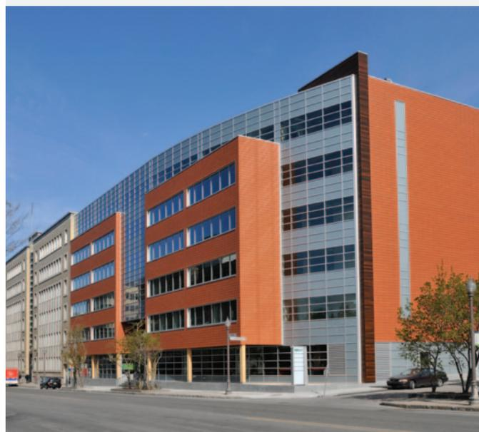
12 Le bénéfice carbone résulte des économies faites par la substitution du béton armé par une structure en bois, tant sur le plan de la fabrication que du transport, ayant ainsi permis d'éviter l'émission dans l'atmosphère d'environ 450 t de CO<sub>2</sub>. De plus, la structure en bois contient 900 t de CO<sub>2</sub> retirées de l'atmosphère par séquestration lors de la croissance des arbres.
