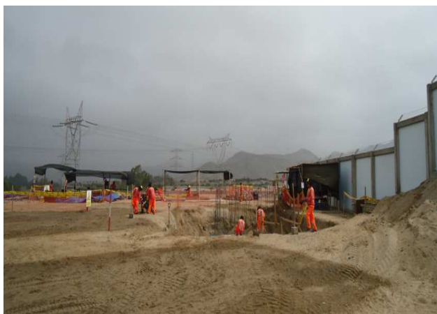
Obra: EPC 500 kV. Chilca y Montalvo y Subestaciones
