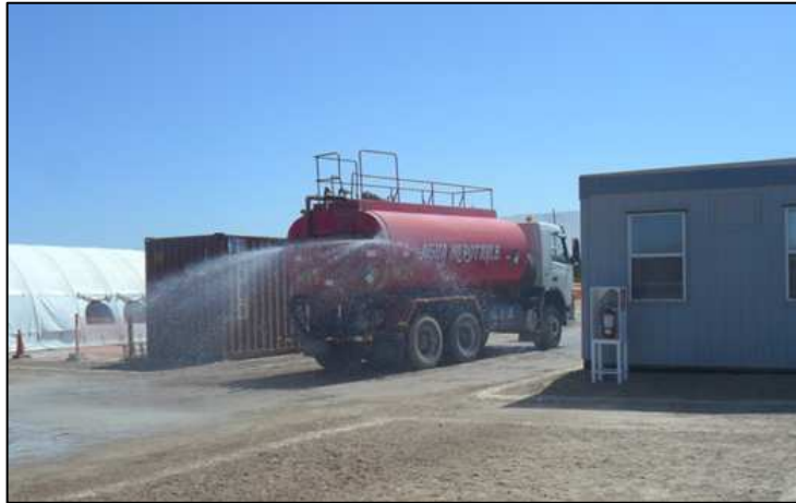
Control para evitar la generación de polvo
