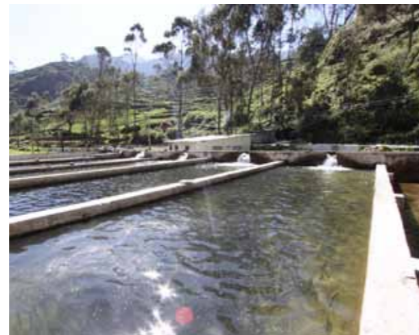
Minicentral generadora en Canta.
