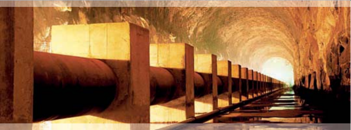
Santa Tereza Voturuá Tunnel Reservoir - Santos São Vicente
