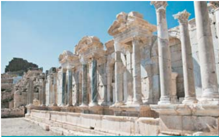
Aygaz Antoninler Çeşmesi Restorasyonu
