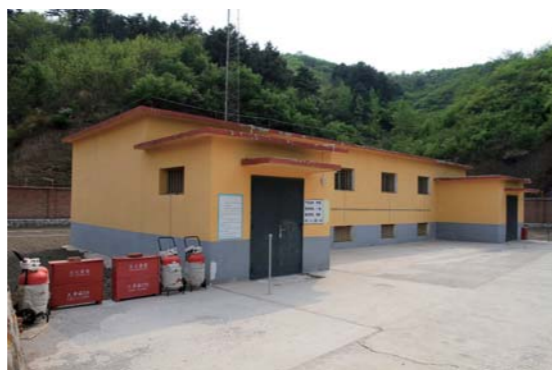
河北东梁公司炸药库
