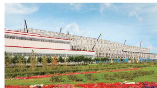
在建中的乌山二期项目
