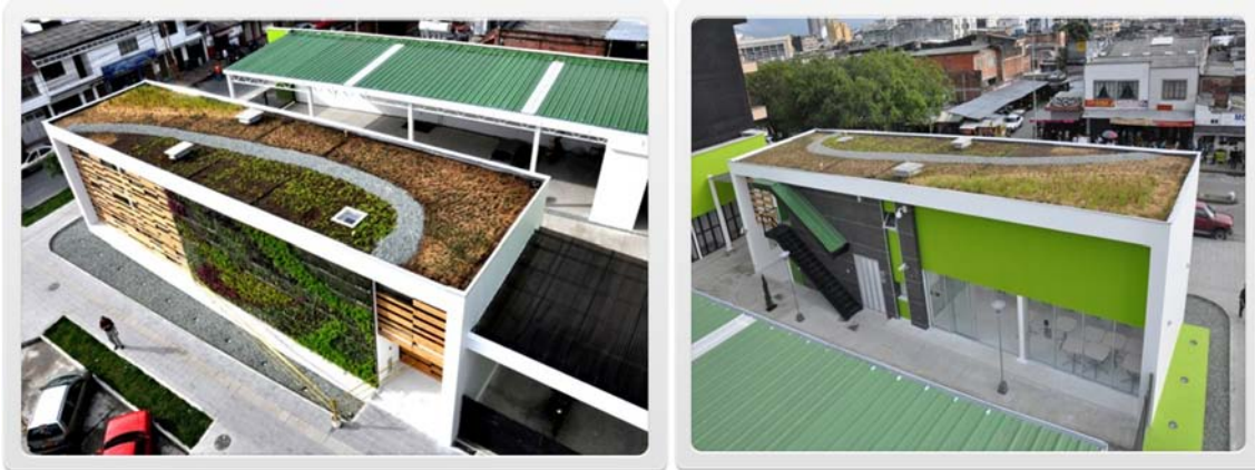
Imagen 3. Sede Mantenimiento de Redes EDEQ S.A. ESP
