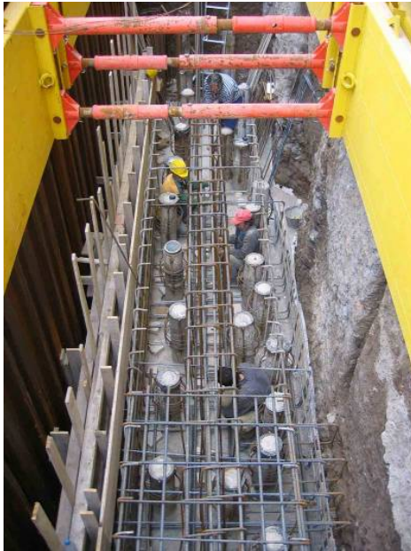
A lato: armatura della trave di fondazione su via Sistina.
