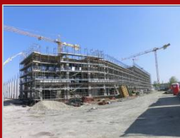
ER.GO - Bologna Direzione Lavori
