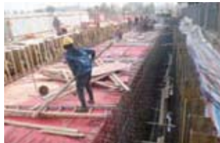
流出防止用緊急廃水貯水槽工事
