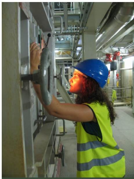
Personal planta de incineración con recuperación energética.
