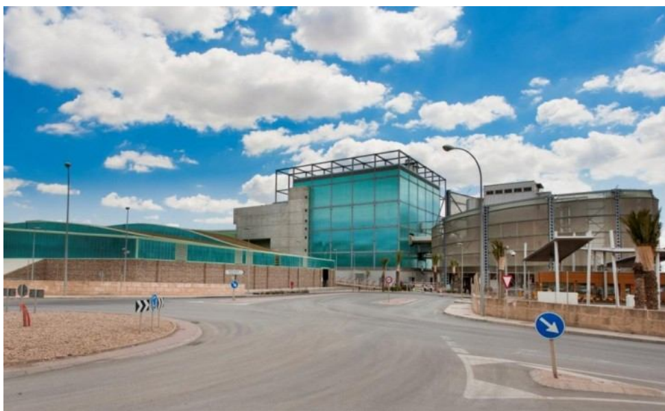
Planta de incineración con recuperación energética.
