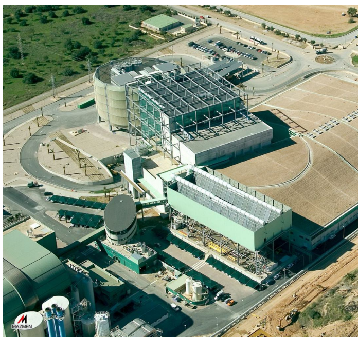
Planta de incineración con recuperación energética.
