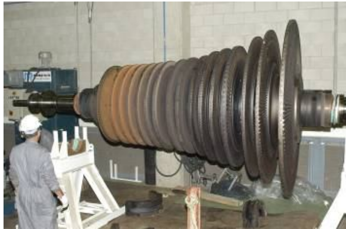
Personal del departamento de mantenimiento de TIRME.
