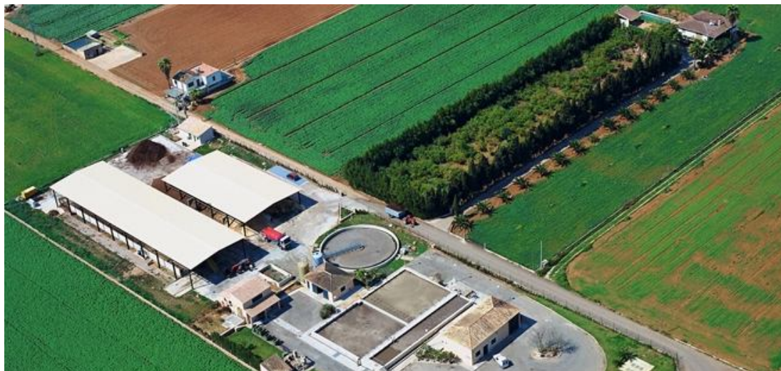
Planta de compostaje de lodos de depuradora.
