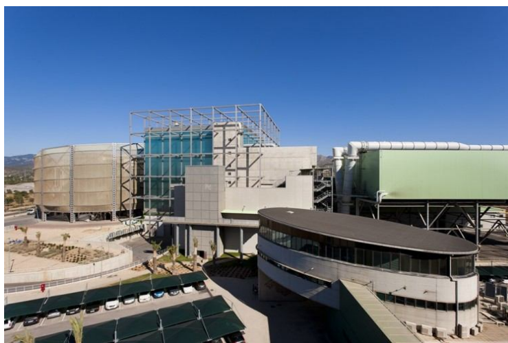
Planta de incineración con recuperación energética.
