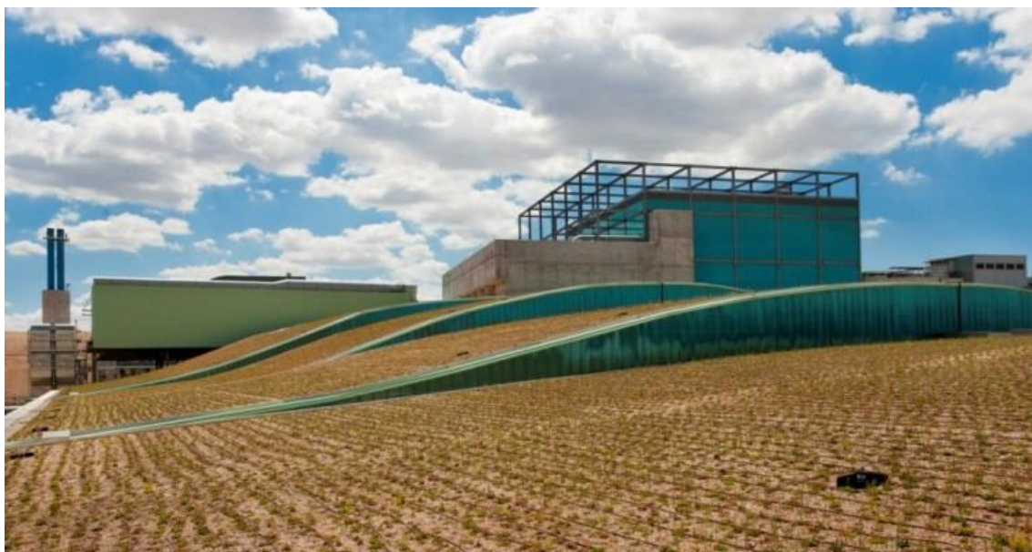
Planta de incineración con recuperación energética.
