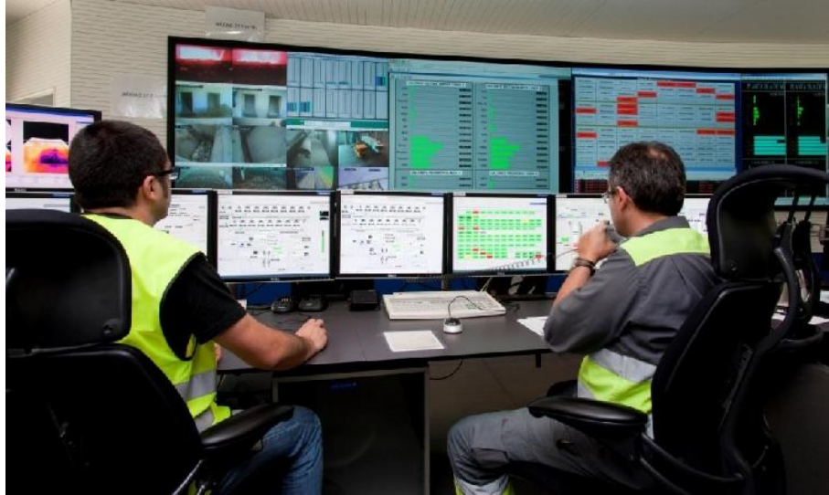
Personal sala de control planta de incineración con recuperación energética.
