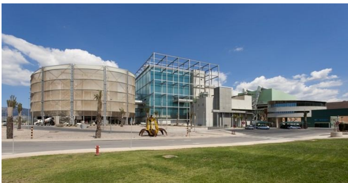
Planta de Incineración con recuperación energética.
