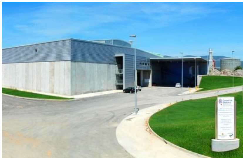
Planta de tratamiento de escorias.
