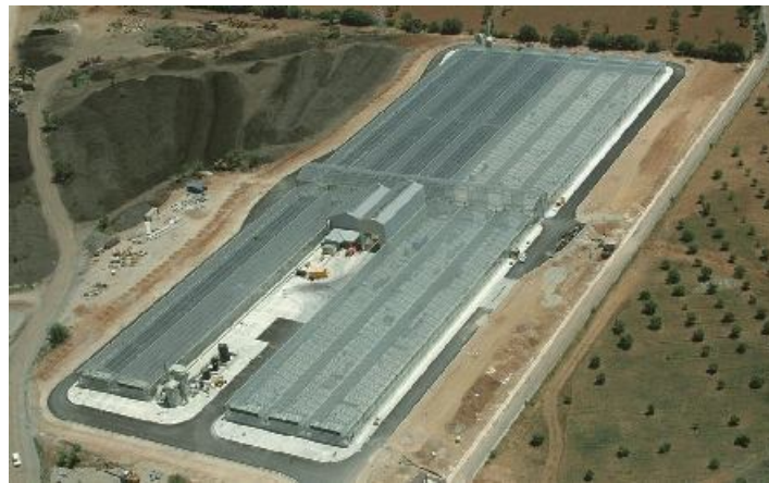
Planta de secado solar de lodos de depuradora.
