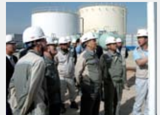
디젤발전 플랜트 이라크 현장
