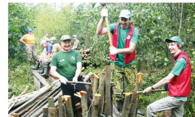
Плотину на Ельнянке укрепляли по «полесскому» методу, который не использовался здесь ранее
