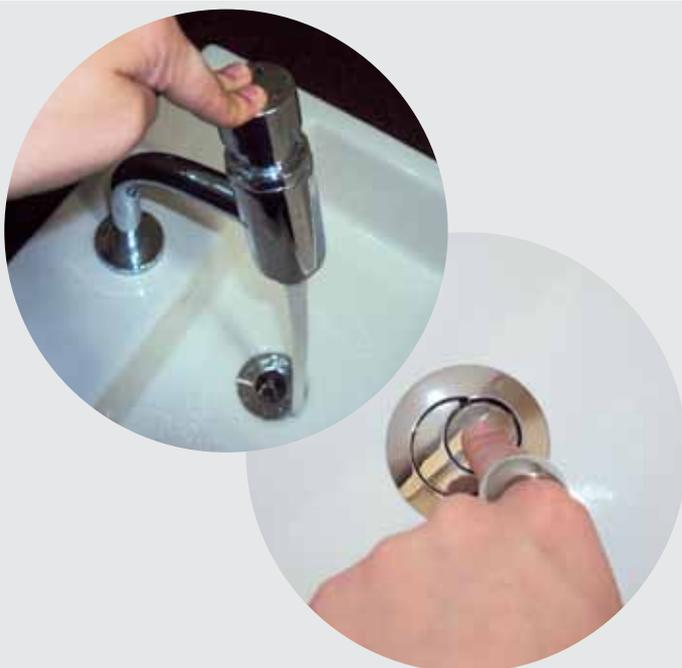
Para economia de água, a sede da MBigucci foi dotada de sistema de reúso de água (captação de águas do lavatório para reutilização nas descargas dos sanitários), torneiras com temporizador, descargas com duplo acionamento (3 litros para líquidos e 6 litros para resíduos sólidos), áreas ajardinadas para escoamento da água para o lençol freático.
