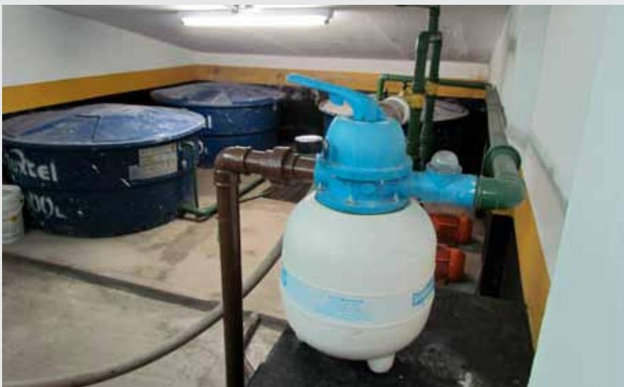
As águas dos lavatórios, chuveiros e bebedouros das áreas de vivência dos canteiros são captadas, direcionadas para um sistema de filtragem e depois bombeadas para uma caixa d'água específica que abastece as descargas dos sanitários das obras. A ação gera uma economia de 20% a 35% de água\*.
