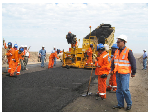
正在施工的秘铁14#采取公路改道工程,2011年6月竣工。
