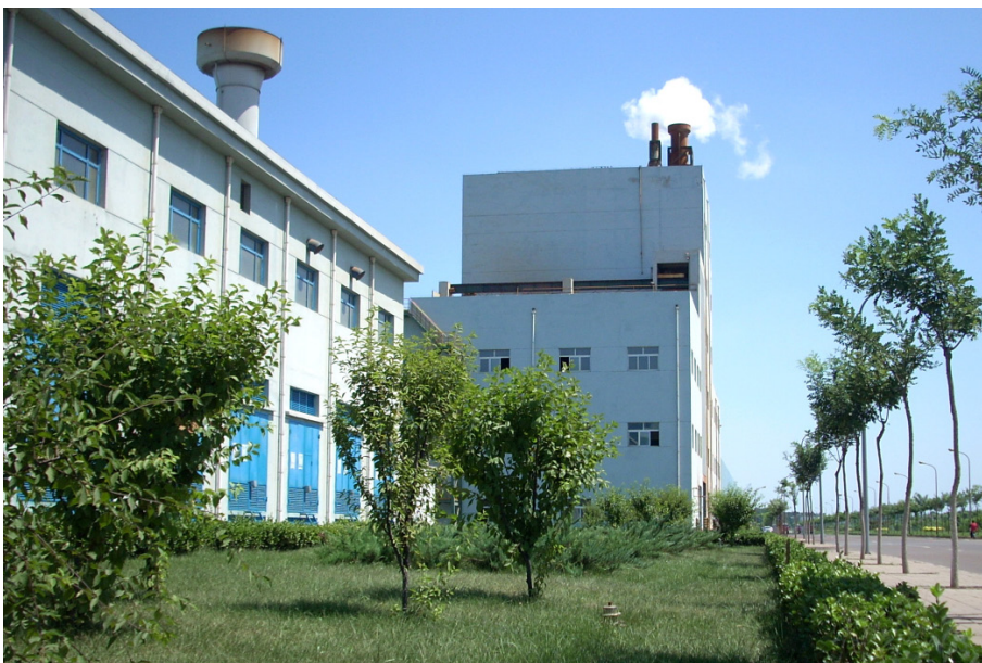
首钢冷轧公司利用中水进行厂区绿化
