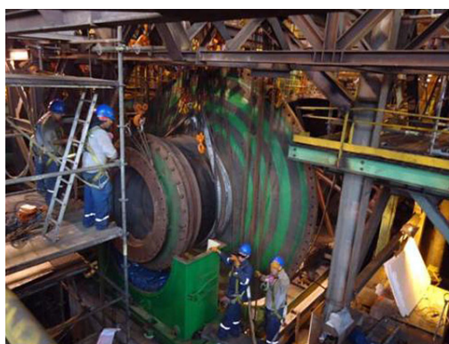
秘铁九系列改造工程施工现场,工人们安装的球磨机,2011年4月投入使用。
