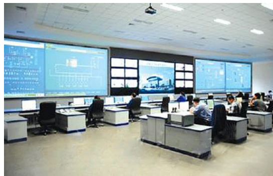
首秦公司能源管控中心
