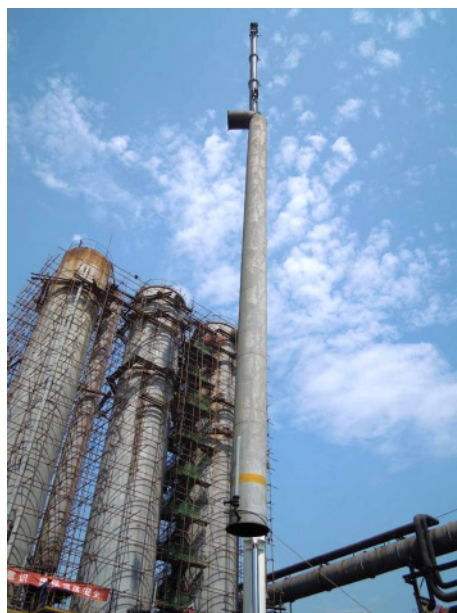
拆除煤气立管
