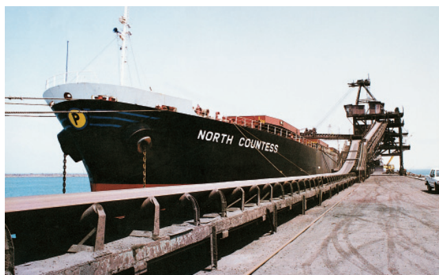
首钢秘鲁铁矿深水码头
