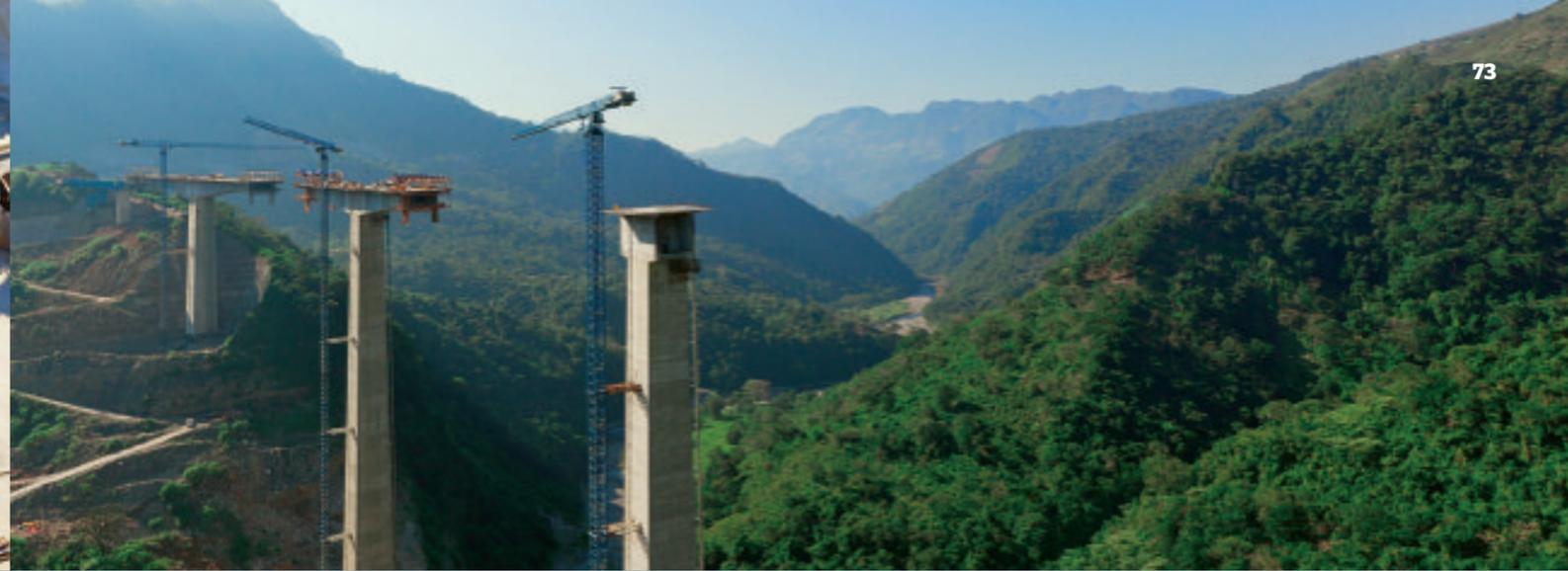
El control geométrico-topográfico en trepados de pilas como en dovelas de la superestructura del puente ha sido muy riguroso, y se realiza mediante equipos de última generación. Se han implementando sistemas de monitoreo permanentes en pilas y superestructura de acuerdo a la etapa en que se encuentra el elemento, lo que permite obtener datos de primera mano que muestran el comportamiento real de la estructura conforme avanza su construcción.
