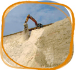
挖掘机正在坡顶进行降坡作业
