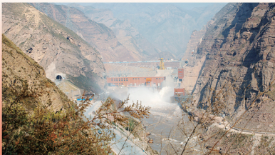
积石峡水电站（3×34万千瓦）是黄河上游龙羊峡—青铜峡河段梯级规划的第五座大型电站，也是我国实施西部大开发和“西电东送”的重要工程。2010年，三台机组全部建成投产。
