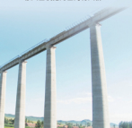
新大白铁路阿山河特大桥
