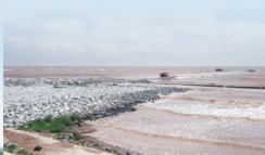
建设中的江苏滨海港
