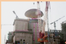
红沿河核电厂二号机组核岛穹顶吊装
