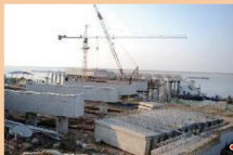
大件码头桩基施工基本完成
