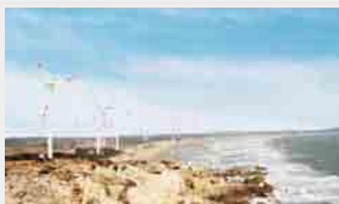
福建分行支持“六鳌风电场”项目 Fujian branch supported "Liua Wind Power Plant" project
