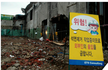
최종 폐석면 잔류 여부 측정
