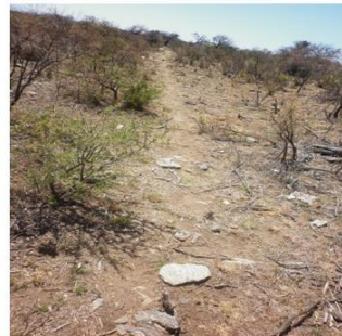
Vista parcial de los 700m de manguera subterránea
