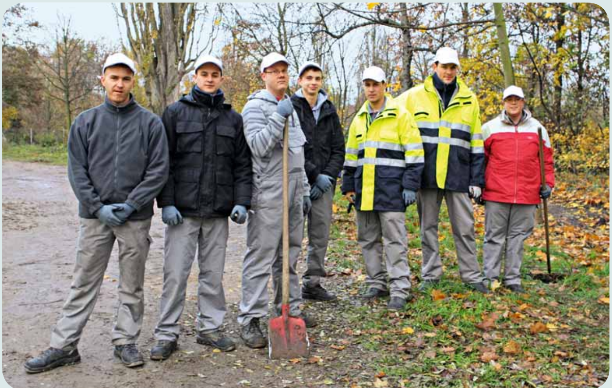
HSE-Mitarbeiter legen beim Bau eines Wildschweinzäuns Hand an.
