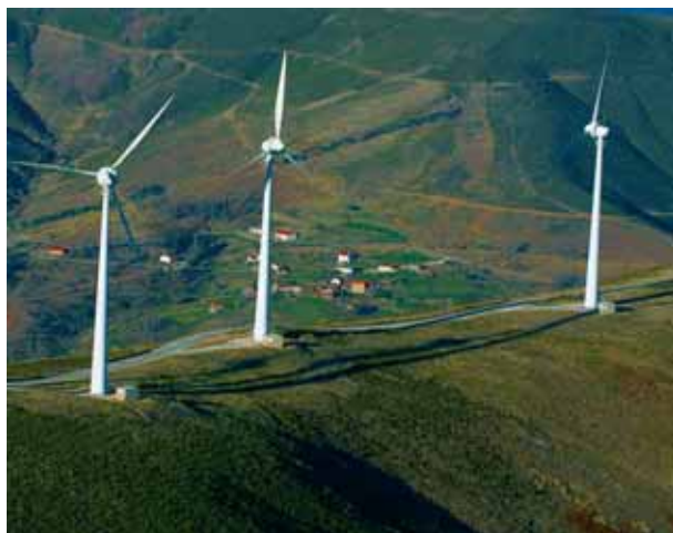
Cabeço da Rainha Wind Farm
