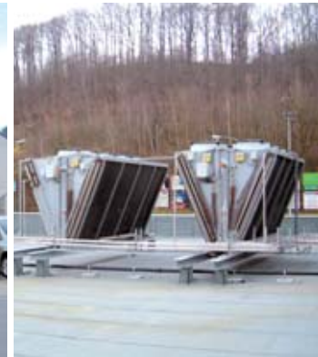
■ Bombas de calor.
