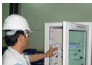
VOC自動監視測定装置
