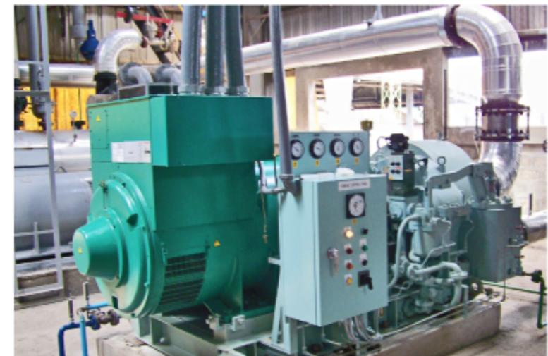
Nueva Turbina SHINCO de vapor para 640 kw / 240 v. / 3ph
