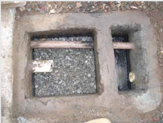
As águas dos lavatórios, chuveiros e bebedouros das áreas de vivência dos canteiros são captadas, direcionadas para um sistema de filtragem e depois bombeadas para uma caixa d'água específica que abastece as descargas dos sanitários das obras. A ação gera uma economia de 20% a 35% de água\*.
