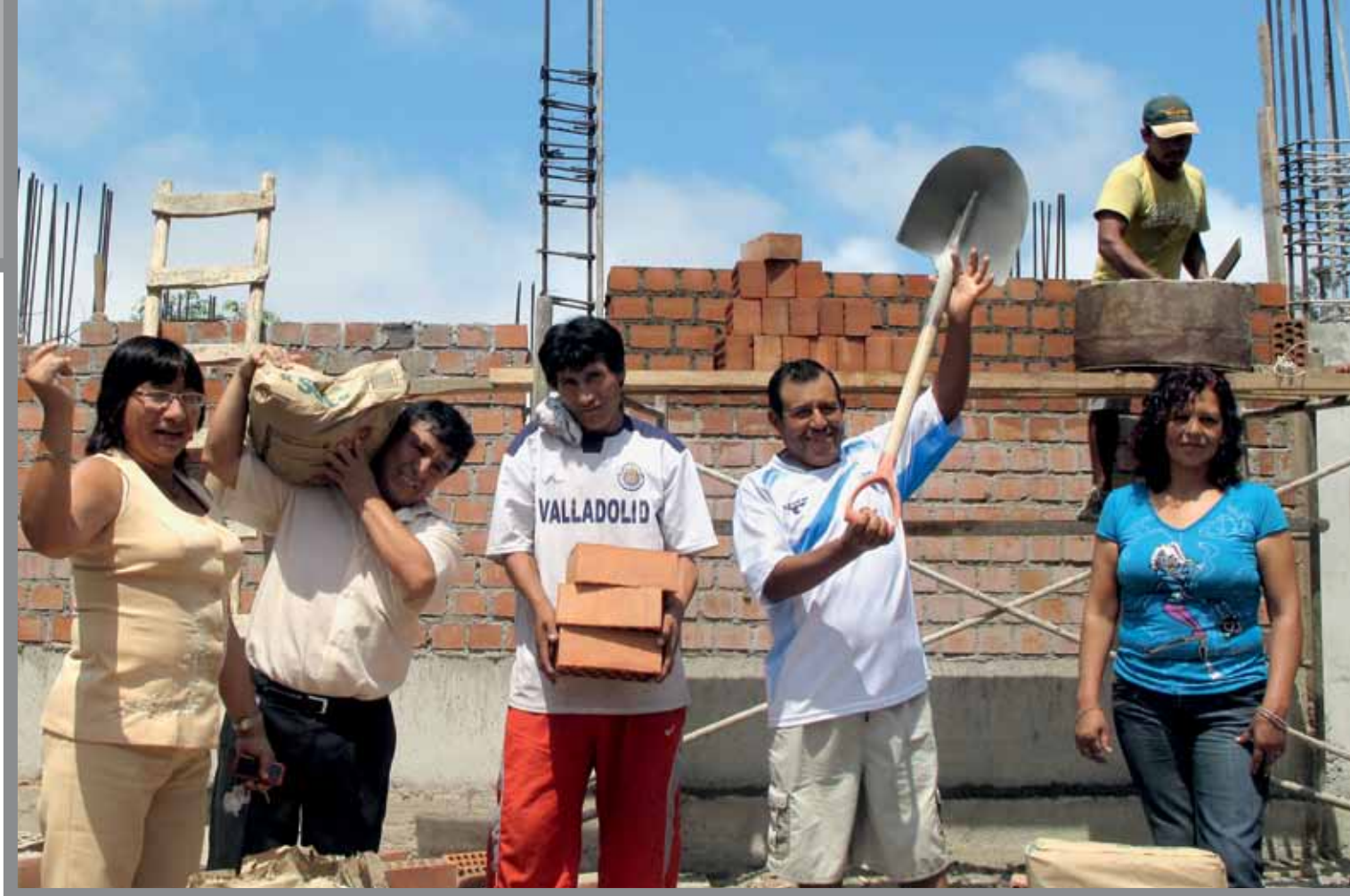
Construcción de aulas para la Institución Educativa N° 6068 Manuel Gonzáles Prada - Villa el Salvador.
