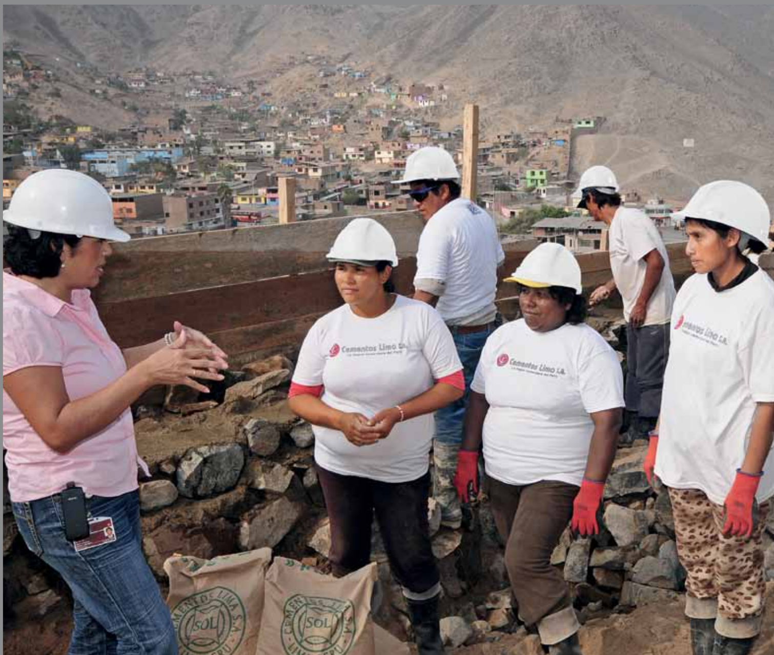
Nuestros profesionales supervisando y asesorando a pobladores en la construcción del Muro de Contención en Comité 11 Sur del Asentamiento Humano de Virgen de Lourdes – Villa María del Triunfo.
