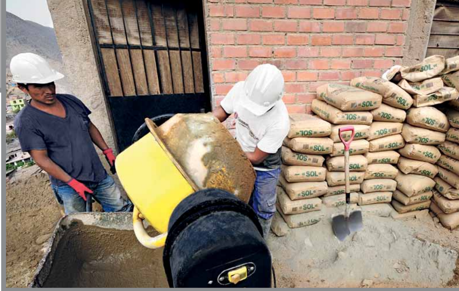
Pobladores del Comité 11 Sur del Asentamiento Humano Virgen de Lourdes -Villa María del Triunfo, mezclando cemento para su obra de saneamiento.
