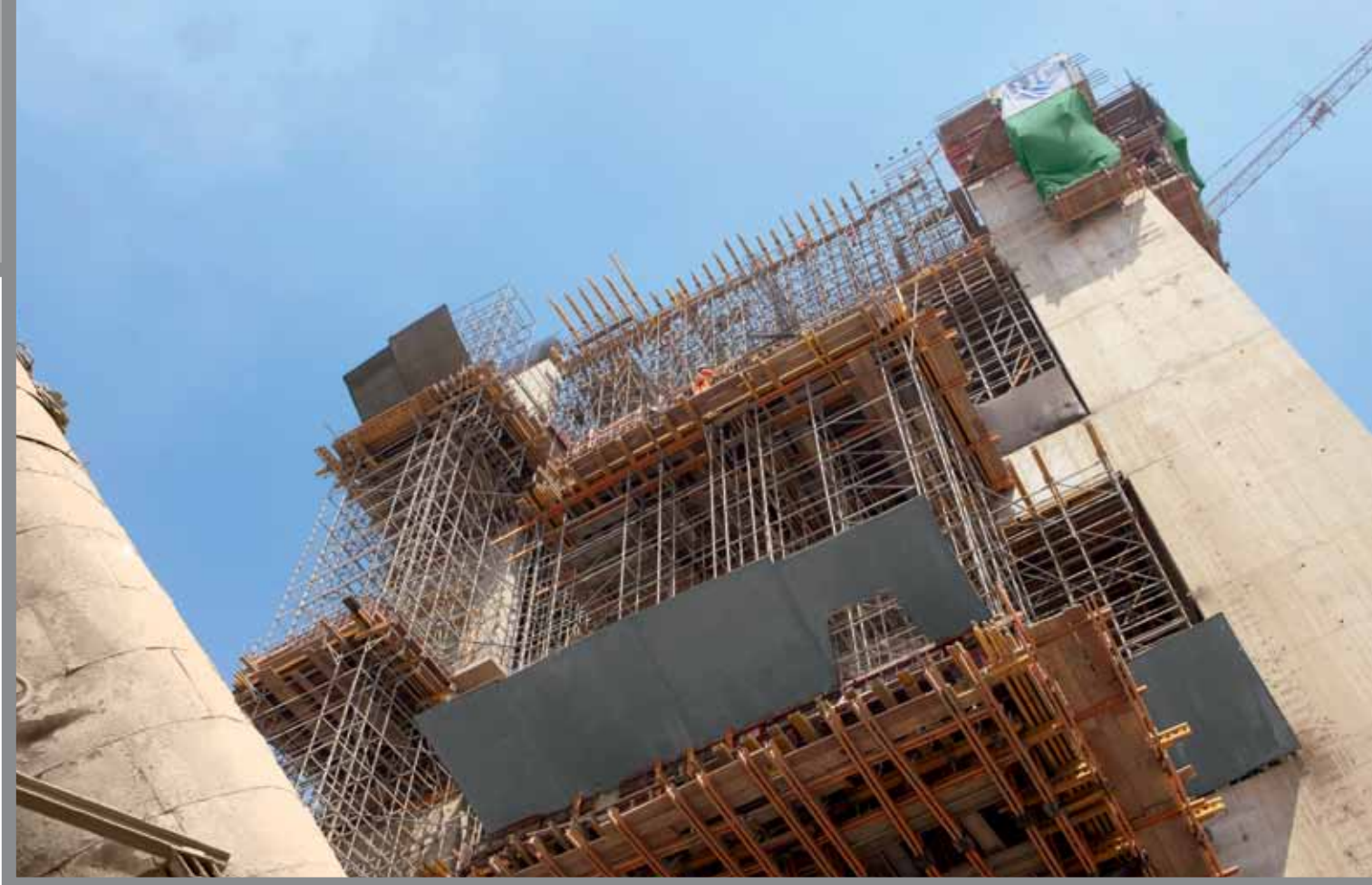
Precalentador del Horno I – Proyecto Ampliación.
