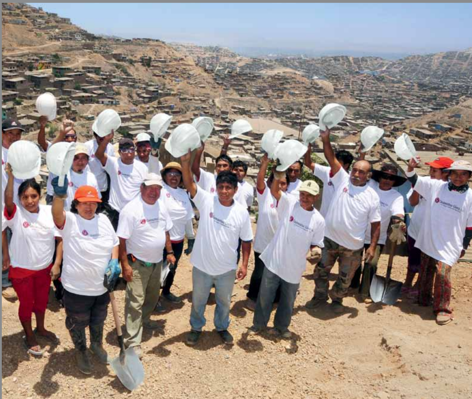
Pobladores del Asentamiento Humano Virgen de Guadalupe de Paraíso -zona de José Carlos Mariátegui-Villa María del Triunfo-, en faena, satisfechos construyendo muro de contención para tendido de redes de agua y saneamiento.
