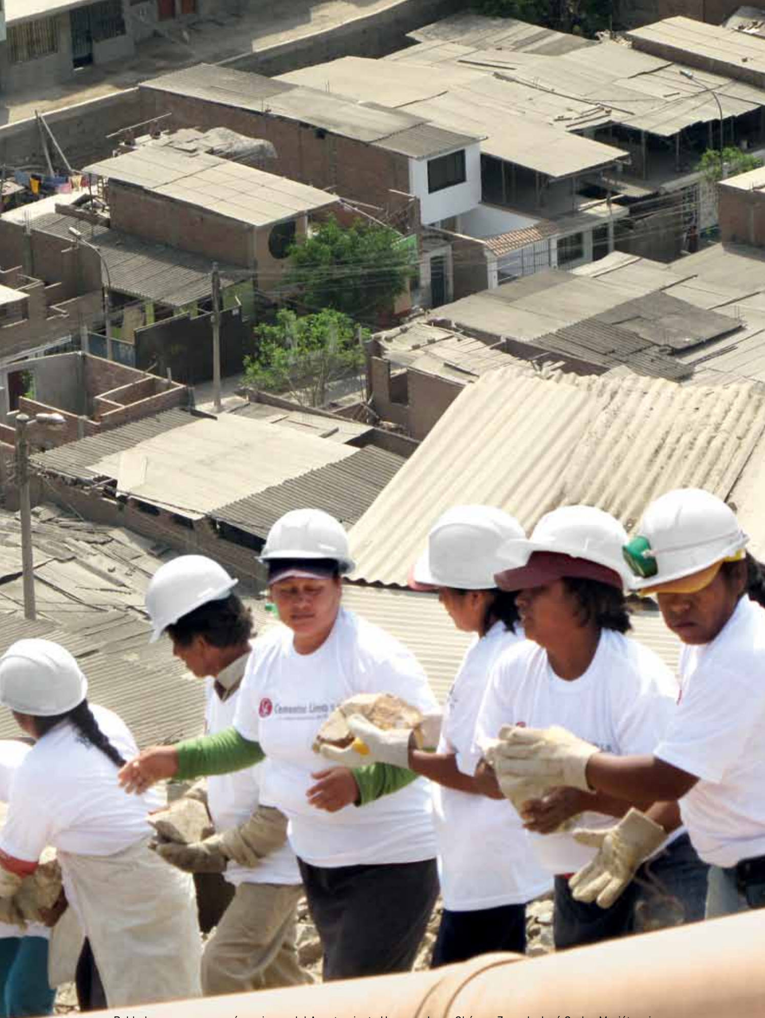
Pobladores, en su mayoría mujeres, del Asentamiento Humano Jorge Chávez -Zona de José Carlos Mariátegui- Villa María del Triunfo-, en faena de construcción de muro de contención, para el tendido de redes de agua.
