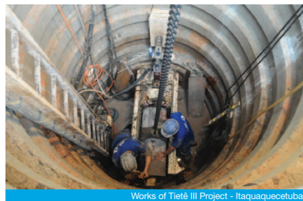
Works of Tietê III Project - Itaquaquecetuba
