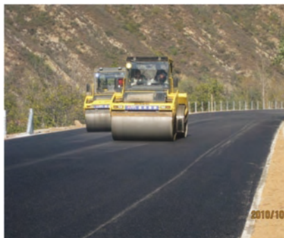
钢渣耐磨沥青路面 用于阜石路建设
