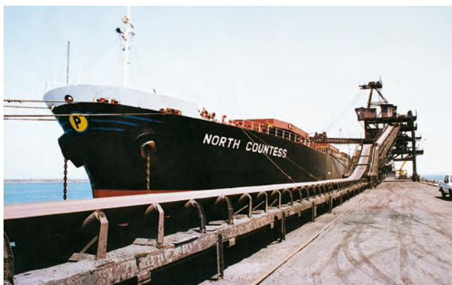
首钢秘鲁铁矿深水码头
