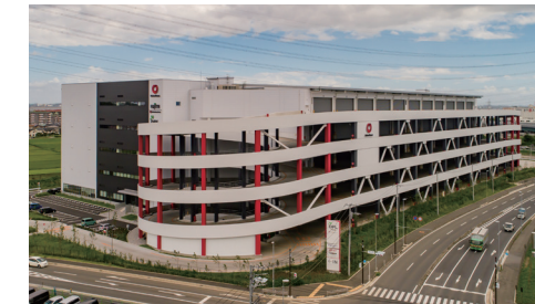
BELS-certified DPL Isehara (Kanagawa Prefecture)
