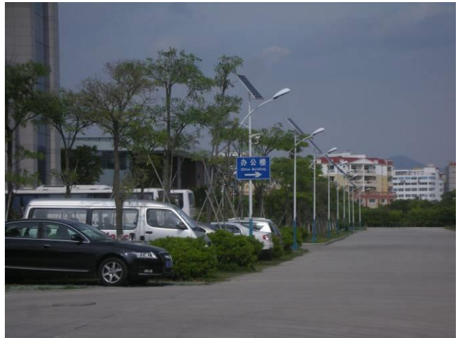
厂内太阳能路灯
