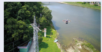
[드론을 이용한 설비 점검]
