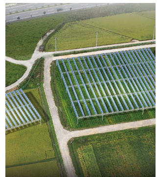
[농업공존형 태양광 실증설비(전남 나주)]
