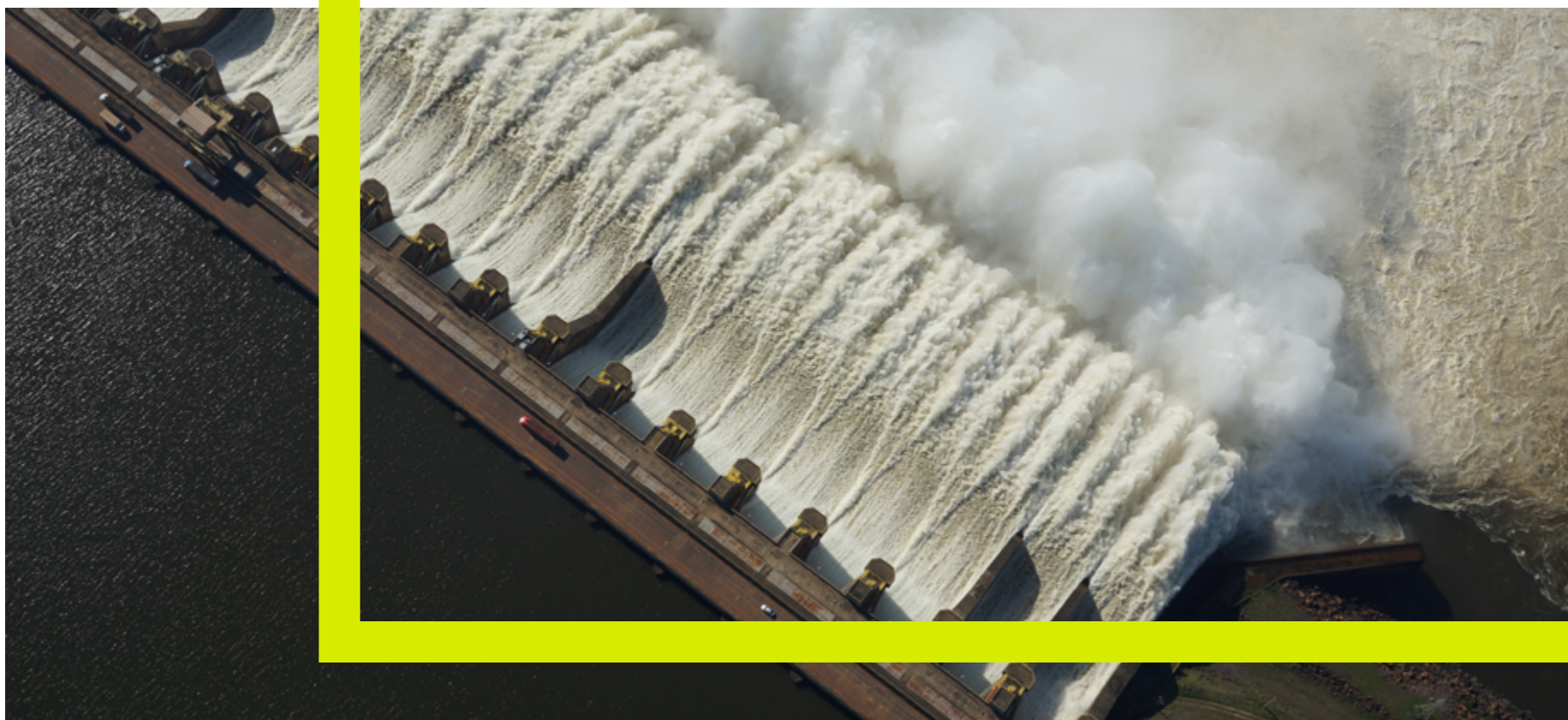
Usina Hidrelétrica de Tucuruí. Foto: Rony Ramos
