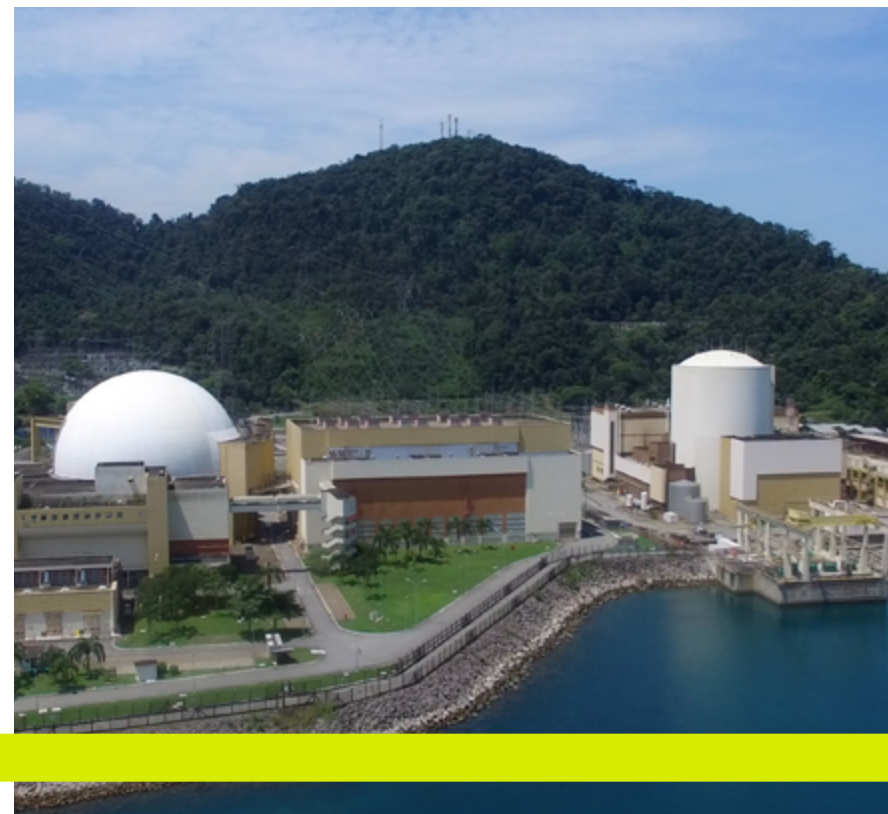
Usina de Angra 2. Acervo Eletronuclear
