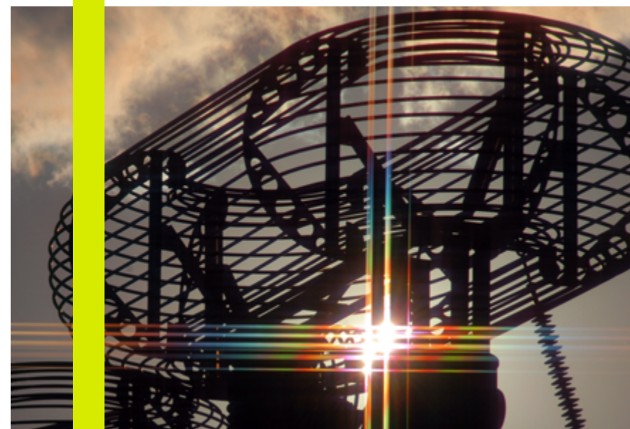
Estrutura do Laboratório de Ultra-Alta Tensão. Acervo: Cepel
