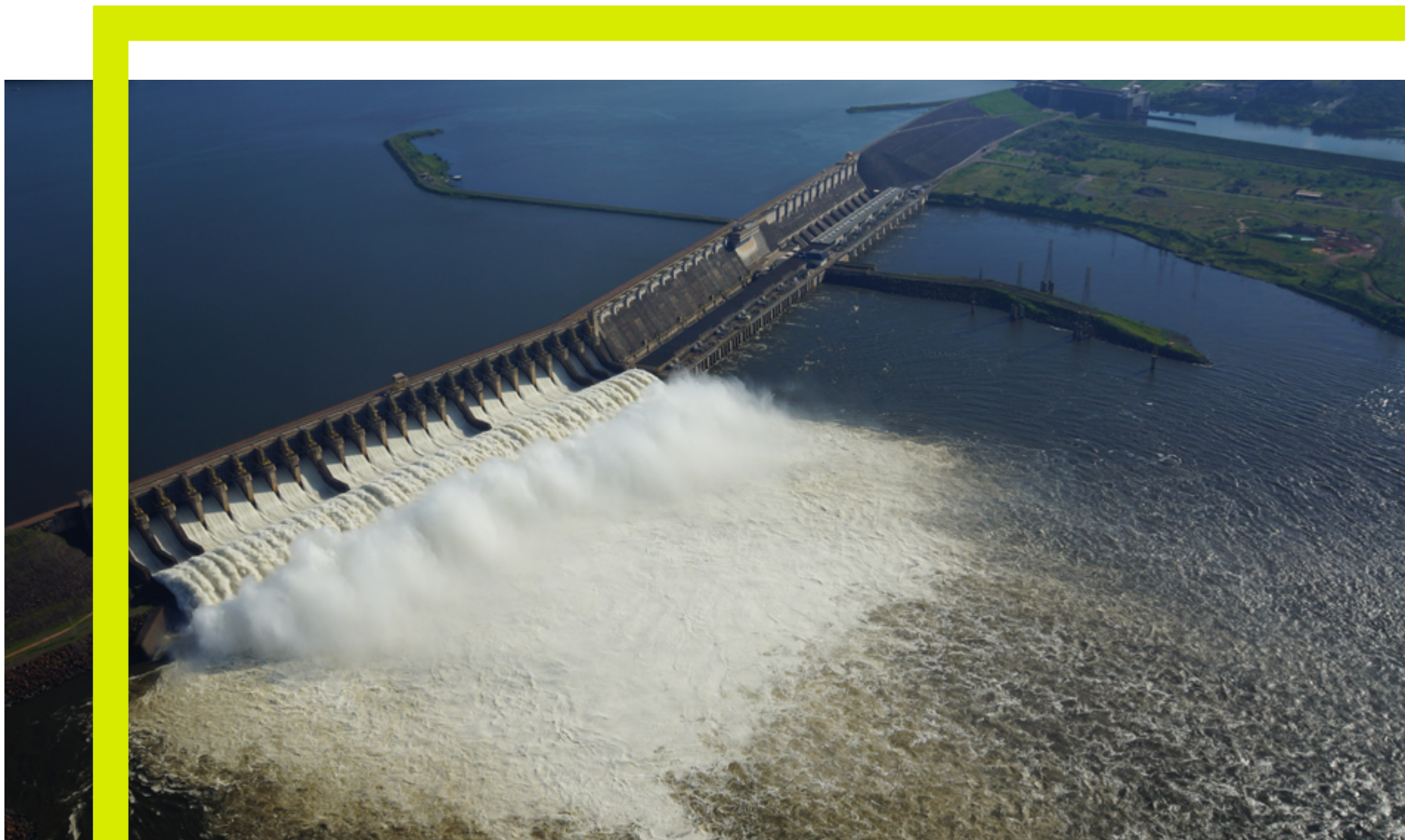
Usina Hidrelétrica de Tucuruí. Foto Rony Ramos
