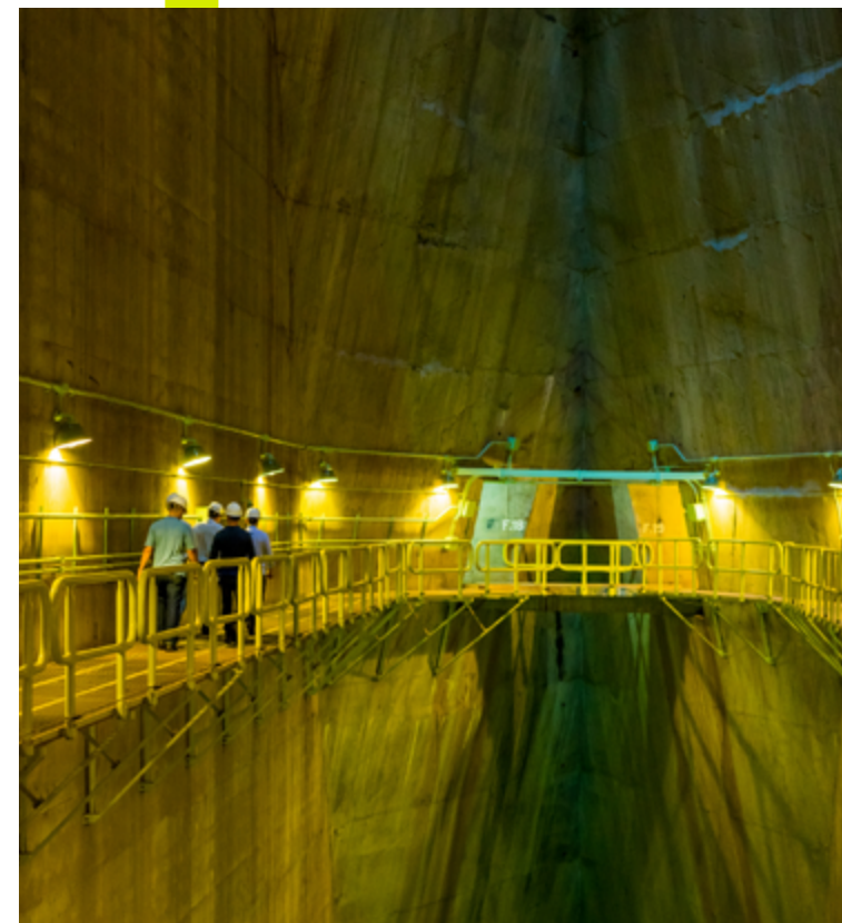
Galerias da Usina. Acervo Itaipu
