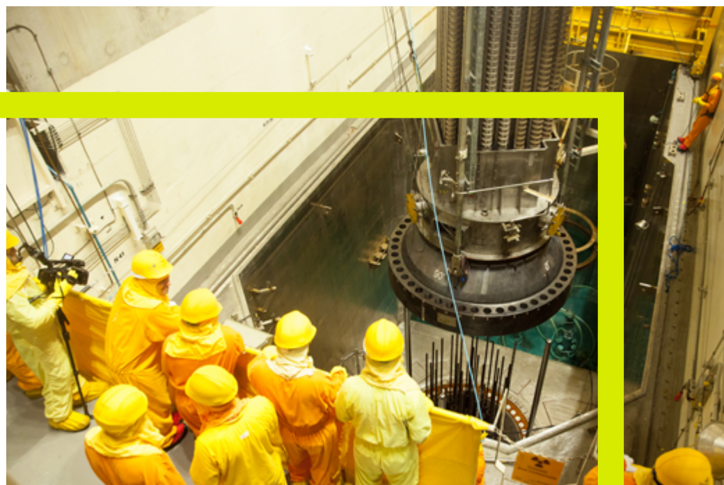
Usina de Angra. Acervo Eletronuclear
