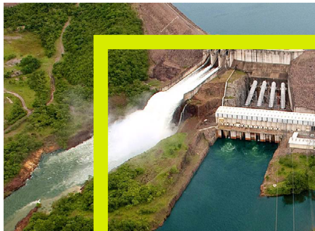
Usina Hidrelétrica de Manso. Acervo Furnas
