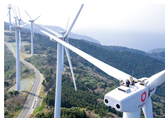
佐田岬風力発電所
