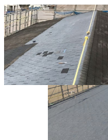
屋根の葺き替え工事
