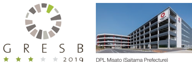
DPL Misato (Saitama Prefecture)
